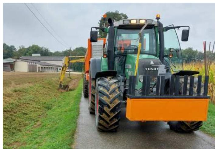
Le fossé n'étant plus fonctionnel, l'entreprise Daubigny a réalisé son curage sur plus de 200 m, permettant ainsi de rétablir une évacuation normale des eaux de ruissellement.
