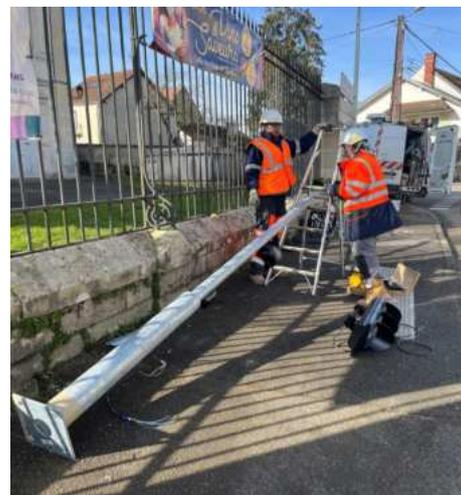
Remplacement complet du feu à la suite de son arrachement par un camion-grumier. Grâce aux caméras de surveillance, la responsabilité de l'entreprise de transport a pu être établie et un constat amiable rédigé. Cette prestation a été entièrement prise en charge par l'assurance du transporteur.
